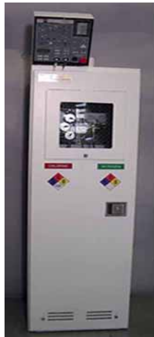
รูปที่ 4.2 ตัวอย่างตู้เก็บแก๊สอันตราย
