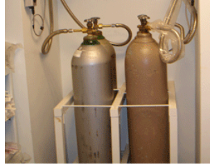
รูปที่ 4.1 ตัวอย่างการวางถังแก๊สที่เหมาะสมในห้องปฏิบัติการ
