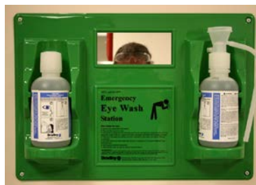
รูปที่ 7.10 ตัวอย่างป้ายบอกบริเวณที่ล้างตา ชุดล้างตาแบบติดผนัง และที่ล้างตา
